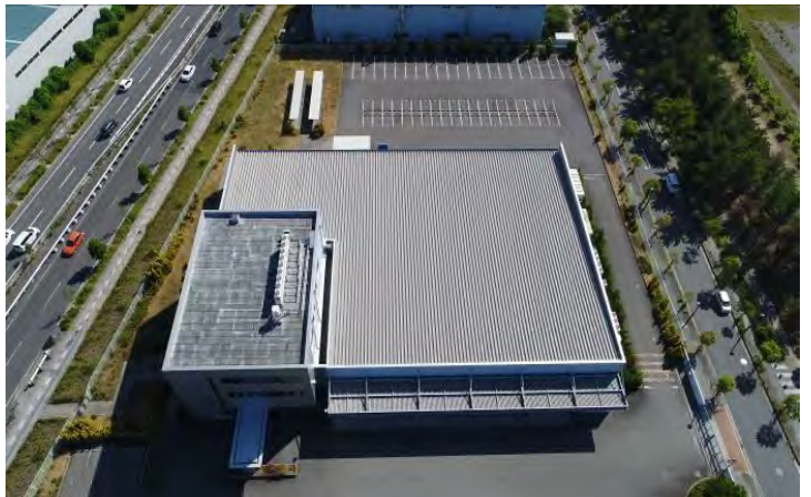
千代田空調機器(株)りんくう工場外観
