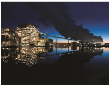
亜臨界圧ボイラ
