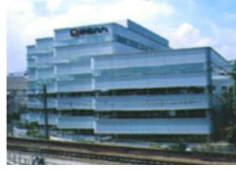
東京支社事務所
